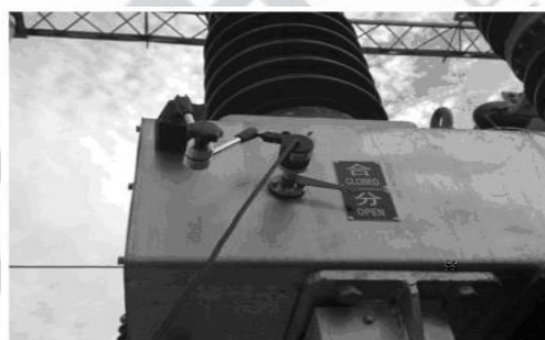
35KV SF6 开关传感器安装
